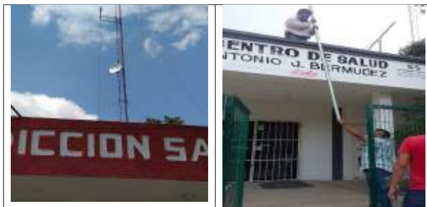
Figura 2.- Docentes instalando antenas de comunicación
